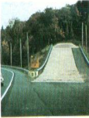
أكوام الرمل الممتصة للطاقة في الطرق الجبلية المنحدرة وخلفها شاحنة طوارئ .
