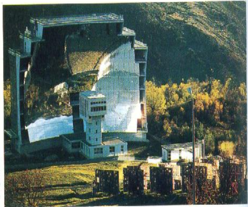
تعكس المرايا المقعرة أشعة الشمس في بؤرة داخل هذا الفرن الشمسي جنوب فرنسا . وتصل درجة حرارة هذا الفرن إلى ما يزيد عن 4000^{\circ}\text{C} عند بؤرة المرآة .
