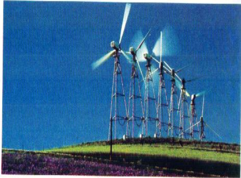
تستخدم الطولعين للهوائية الحديثة سرعتها الزاوية لتشغيل المولدات الكهربائية .
